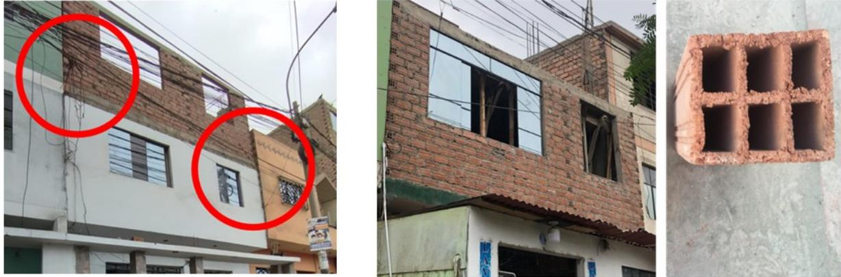
(A) Viviendas sin juntas de separación sísmica.
