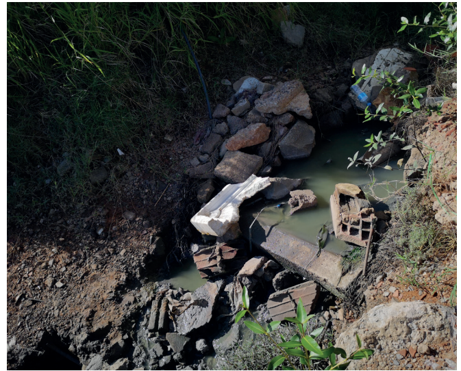
Figura 4: Impactos da urbanização sobre as áreas de manguezal (a) muro de vedação de um condomínio de luxo, construído sobre a área de manguezal, obstruindo o fluxo normal do aporte de sedimentos (b) Esgoto a céu aberto sem o devido tratamento.
