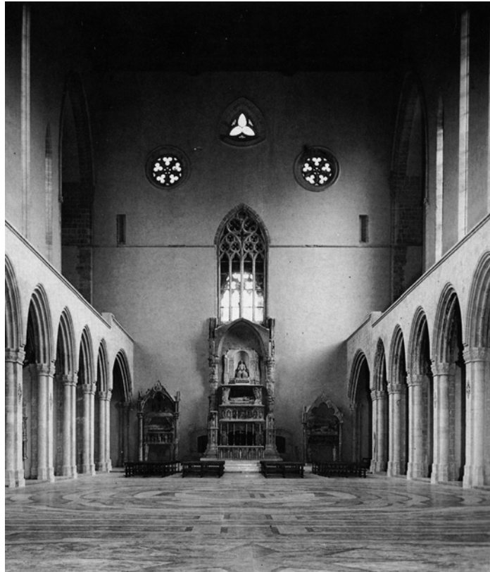
SANTA CHIARA, NAPLES. Interior, after the restoration. Image: G Dell'Aja, Il restauro della Basilica di Santa Chiara in Napoli, Napoli, 1980.
