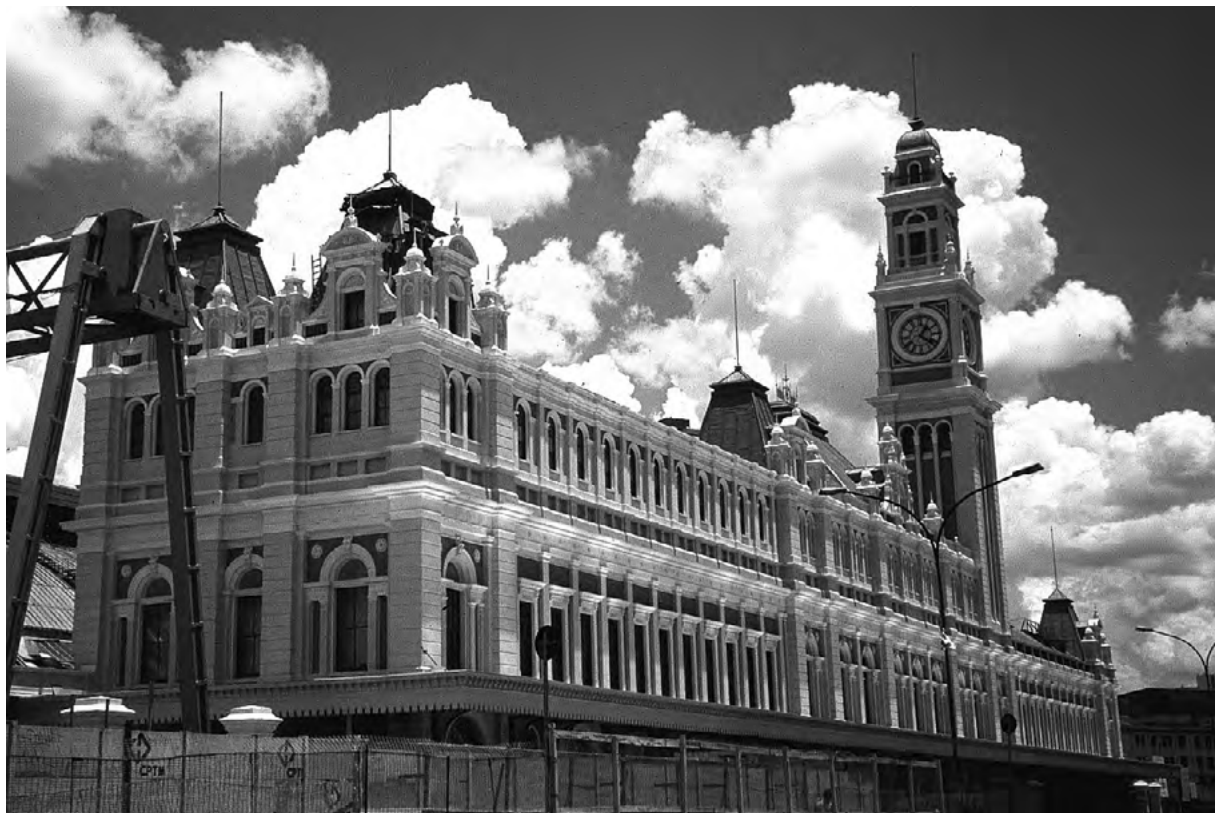
ESTACIÓN DE LUZ . Ciudad de Sao Paulo (Brasil). Después de la intervención, 2004. Imagen de la autora.
