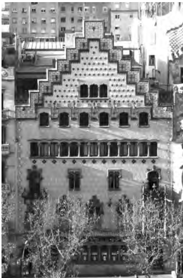
FIGURA 5. CASA AMATLLER. Vista de la fachada, estado actual. Imagen: Fundación Montemadrid. 36
