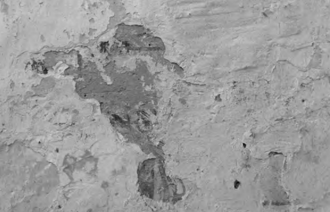
FIGURE 1. EGLISE DE BARENTON-BUGNY. Badigeon écaillé sous laquelle apparaît la polychromie. Image : © A. Timbert.
