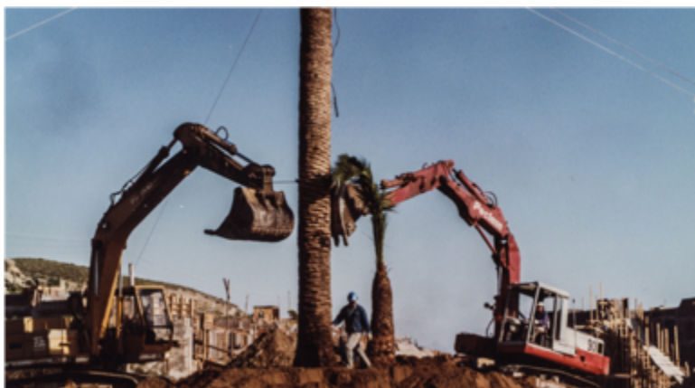
Figura 12. Fotografía de construcción del centro turístico Las Tacas, IV región, Chile. La fotografía es parte del archivo personal de la autora, tomada por Gustavo Montero Saavedra. Fecha desconocida.
