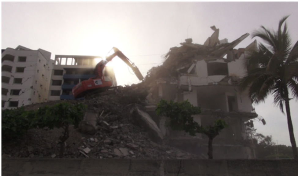
Figura 13. Demoliciones en la ciudad, 2016.
