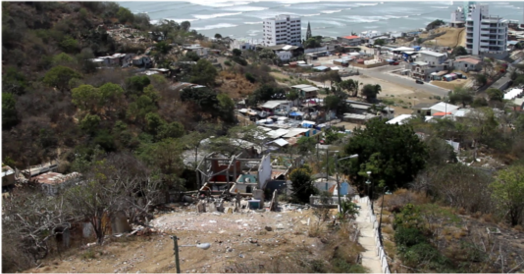
Figura 8. Vista panorámica del barrio San Roque con casas derrumbadas y albergue al fondo, 2016.
