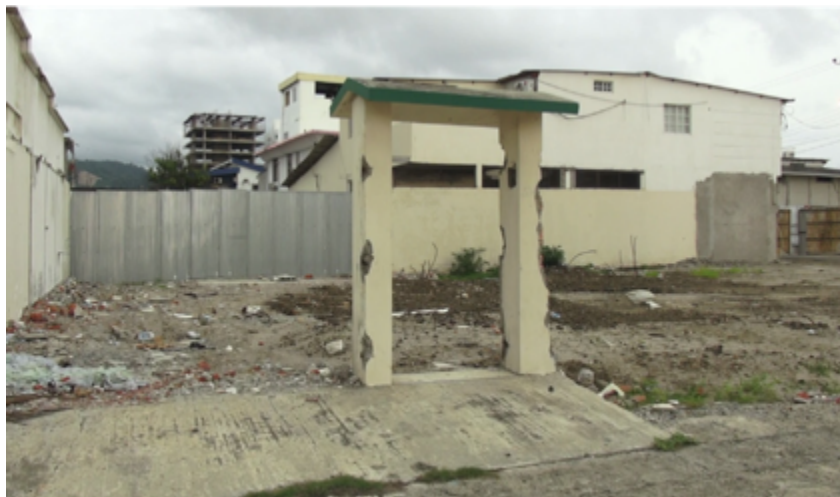
Figura 1. Restos de edificio, 2016.
