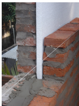
Fig. 20 Aislación térmica paredes
