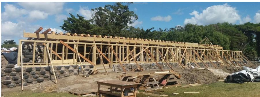
Fig. 1 Etapa de Obra de la Escuela Sustentable Fuente propia.
