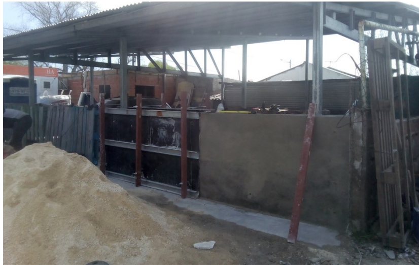
Figura 4 Los muros de árido vertido mejorados en “La Trinchera” Elaboración propia
