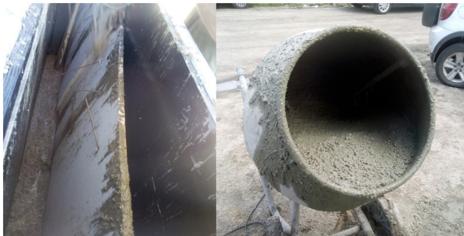
Figura 5 Construcción del Muro 2 (izquierda) y la mezcla del Muro 3 (derecha) Elaboración propia
