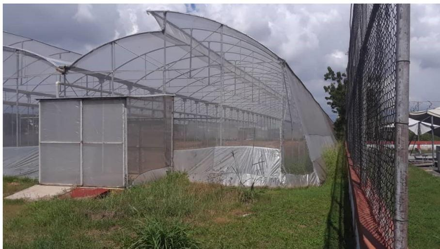
Figura 8. Invernaderos con techo curvo a dos aguas con jaula trampa para plagas y patógenos.
