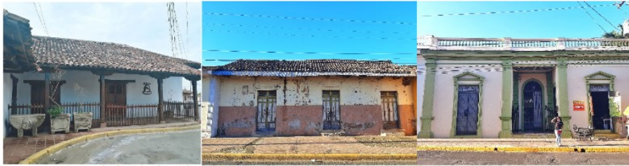
Figura 8: (Leer de izquierda a derecha) Singular modelo de vivienda con galería porticada (Casa Palenque o El Recodo), Arquitectura colonial tradicional dintelada sobre Calle Real Xalteva y Casa neoclásica de un nivel sobre misma calle. Propia.
