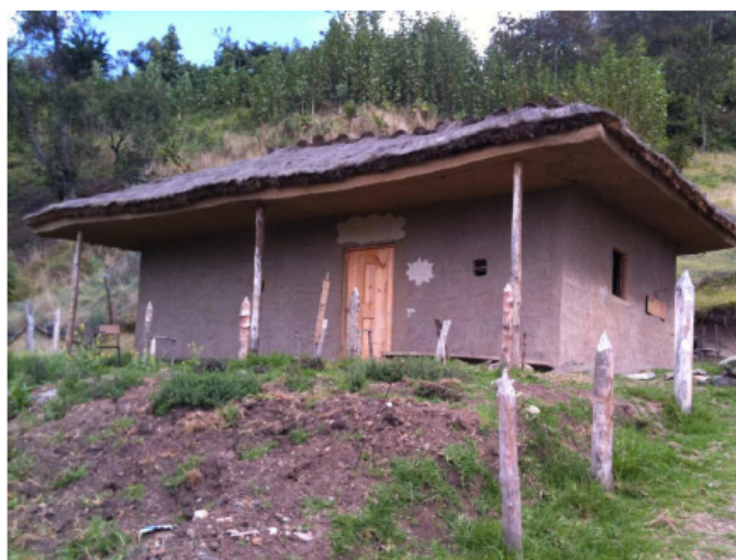
FIGURA 4. Vivienda típica del Totoro elaboración propia, septiembre, 2013, municipio de Totoro.
