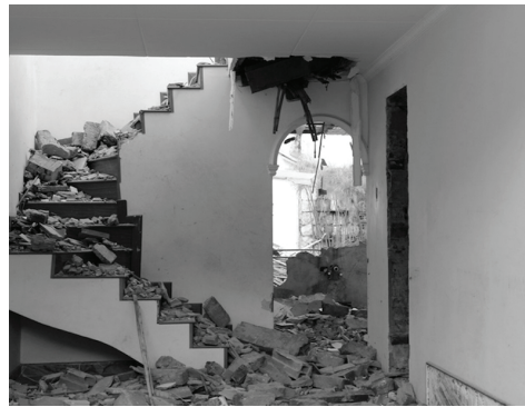
Figura 1. Demolición de una casa cualquiera en Bogotá
