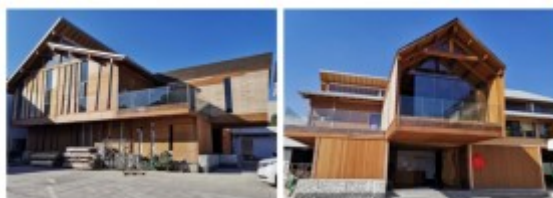
FIGURA 1. Ilustración de la edificación de LBL completada [23]
