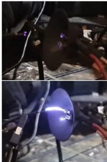
FIGURA 9. Formación de efecto corona y ruptura dieléctrica, circuito 1.
