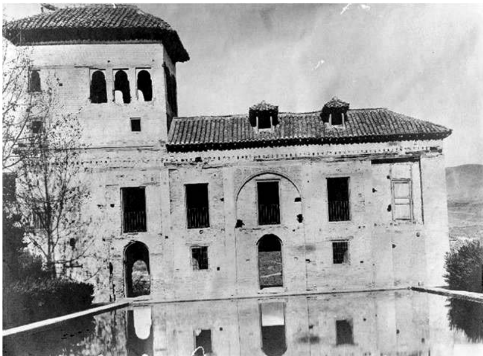
FIGURA 7. PALACIO DEL PARTAL. Antes de la restauración de Leopoldo Torres Balbás. Imagen: Archivo del Patronato de la Alhambra y Generalife.
