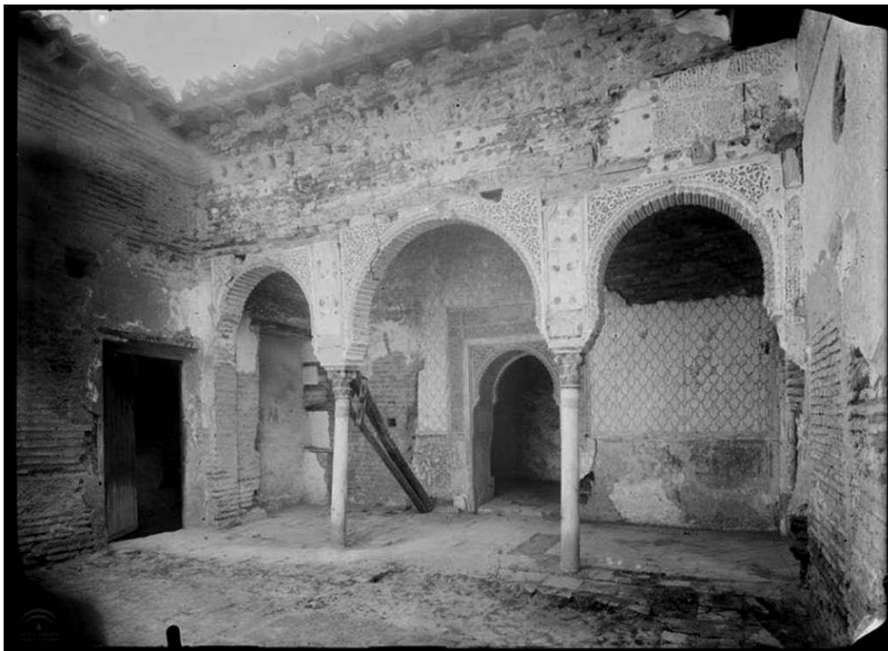
FIGURA 5. PATIO DEL HAREM. Palacio de Los Leones de La Alhambra de Granada antes de su restauración. Imagen: Archivo del Patronato de la Alhambra y Generalife.
