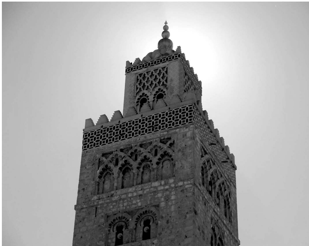
FIGURA 10. ALMINAR DE LA MEZQUITA ALMOHADE DE LA KUTUBIA DE MARRAKECH. Estado tras la restauración de la azulejería de su zona alta mediante técnicas tradicionales. Imagen: Pablo Herrero Lombardía.
