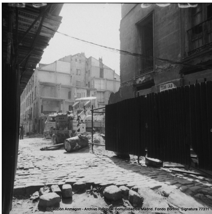
FIGURA 3B. VISTA DE LA CALLE DE HERMOSA, EN EL BARRIO DE LAS POZAS, MADRID, DURANTE EL PROCESO DE DERRIBO DE LAS VIVIENDAS, OCTUBRE 1969. Imagen: Colección Anmagon, Archivo Regional de la Comunidad de Madrid, Fondo Portillo, signatura 77311-023.
