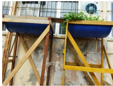
FIGURA 6 Estrutura de sustentação das wetlands
