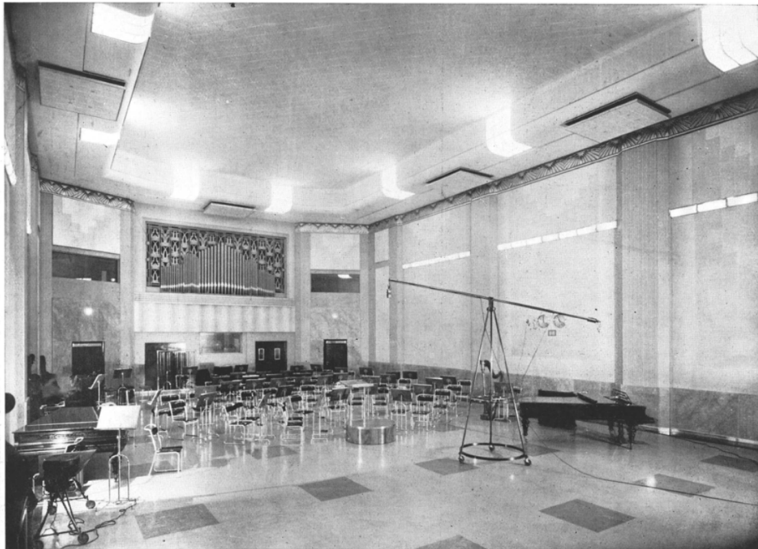
ARQ. A. G. SPANDRI. Edificio para L. R. 1 Radio El Mundo.- El Estudio A
