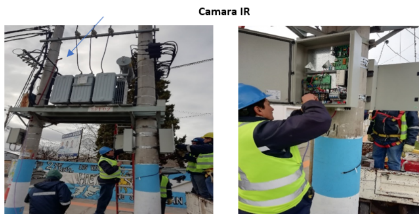
FIGURA 18 Instalación del equipo en la SET.
