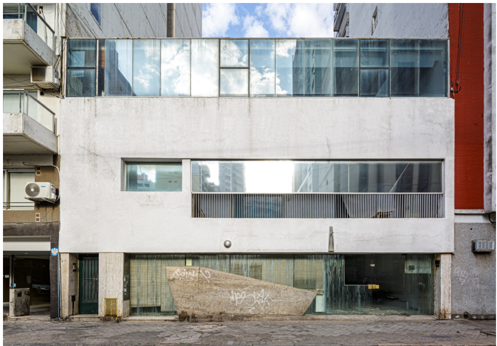
Imagen actual fachada calle Mitre.
