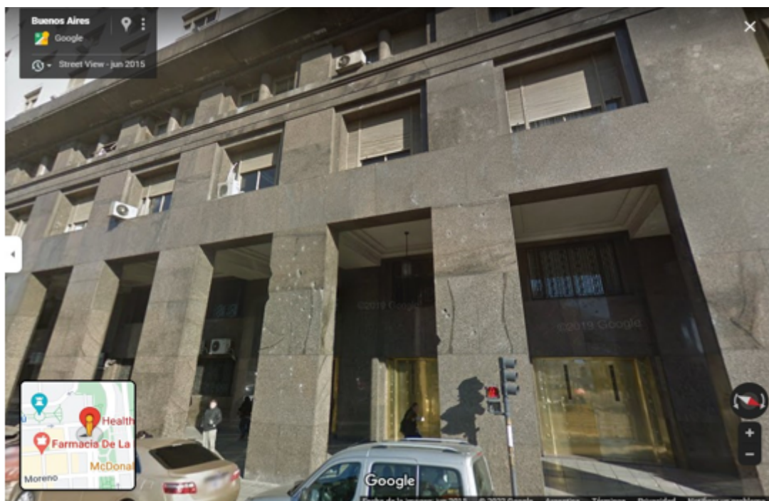
Fachada del edificio sobre Av. Paseo Colón
